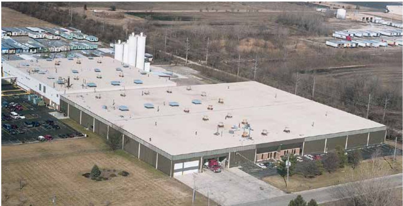
USINE DE WEST CHICAGO, IL, É.-U.
